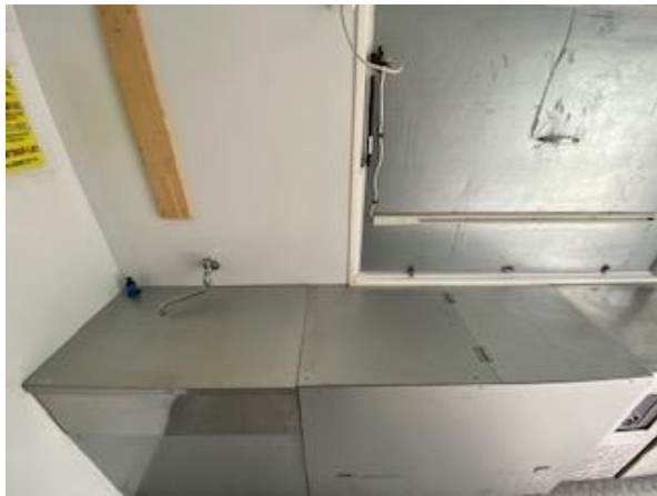
作業台、2槽シンク (蓋つき) (200Lタンク)
