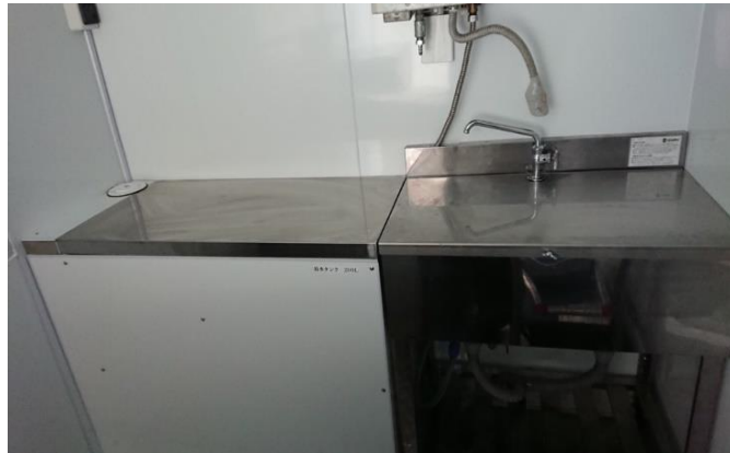
作業台、2槽シンク (蓋あり) (200Lタンク)
